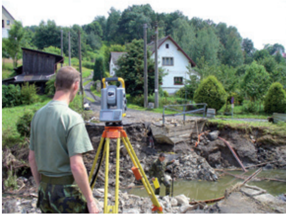
Geodetické zaměření výstavby provizorního mostu v obci postižené povodní.
