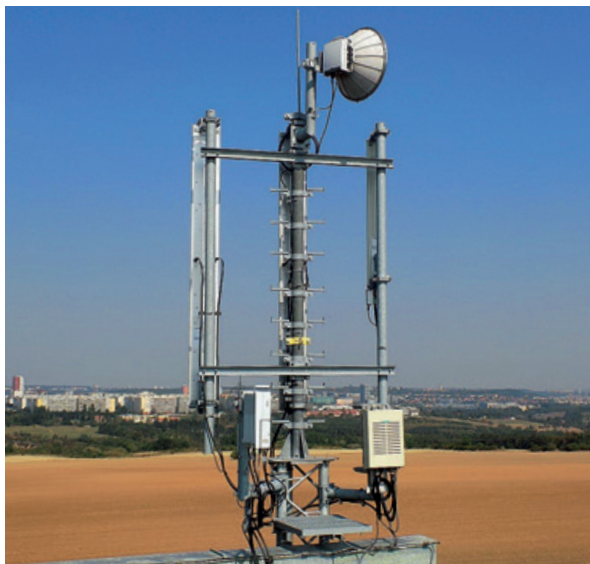
Obr. 1. Anténní systémy a rádiové jednotky základnové stanice.
